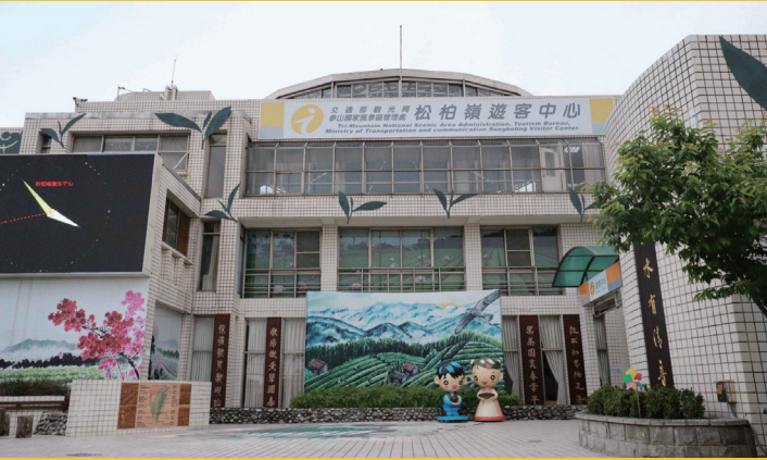
松柏嶺遊客中心 Songboling Visitor Center
